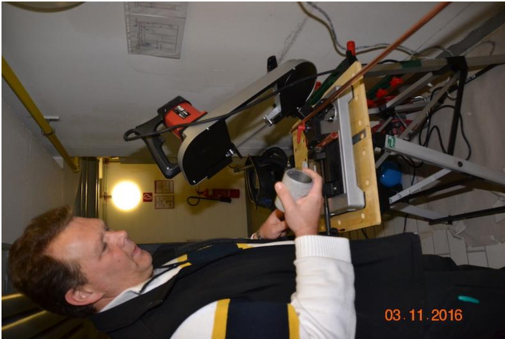
Bild 5: Entgraten der Rohrleitung: hier mit einem Universalentgrater
