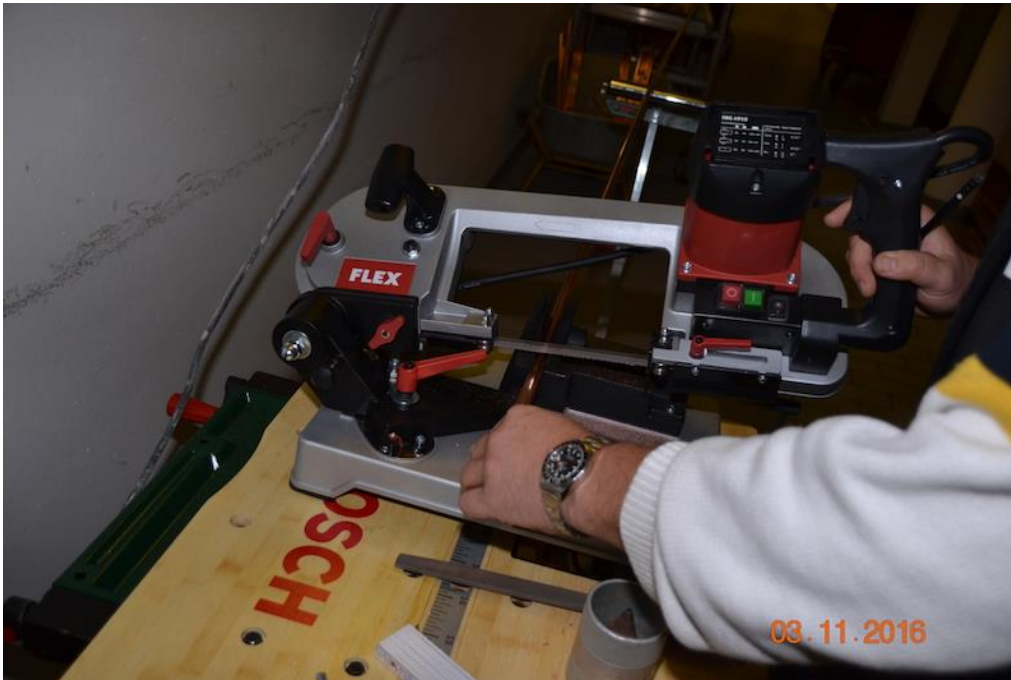
Bild 3: Fachgerechtes Ablängen der Rohrleitung: hier mit einer Bandsäge
