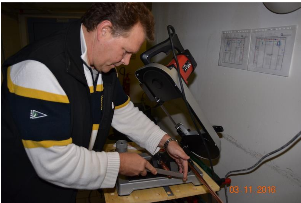
Bild 4: Entgraten der Rohrleitung: hier mit einer Feile
