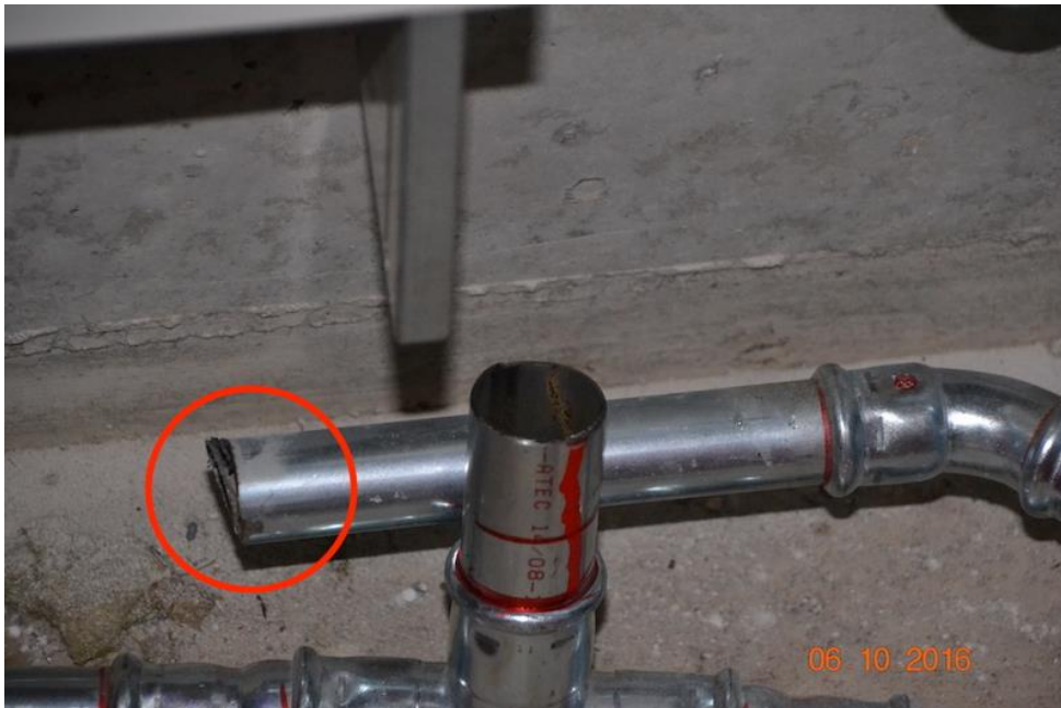
Bild 9: Schräge Schnittkante hier: C-Stahl
