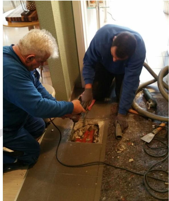
Bild 1: Typische Vorgehensweise bei Havarieschaden (Wasserrohrbruch), an den asbesthaltigen Fliesenkleber denkt in diesem Moment niemand (zur Verfügung gestellt von Dr. Fuehres)
